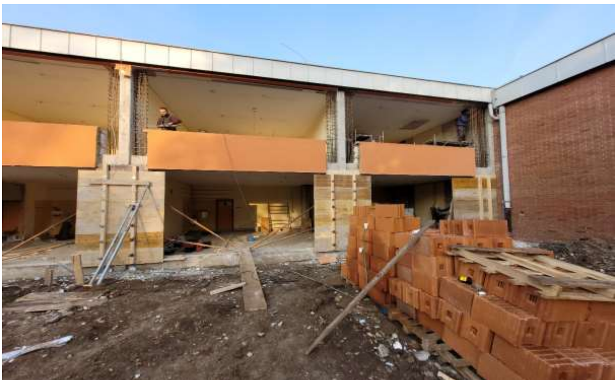
Slika 7 Ojačitev podpornih stebrov (12.10.2022)
