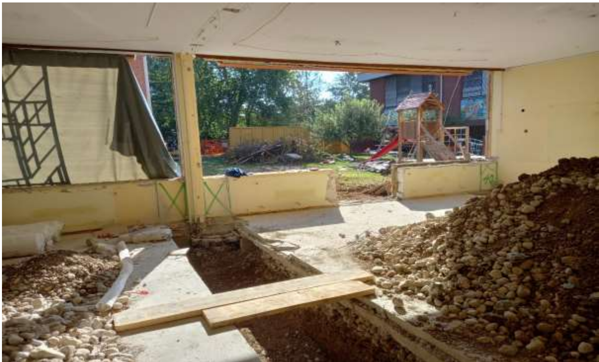
Slika 2 Izkop temeljev za ojačitev zgradbe (06.09.2022)
