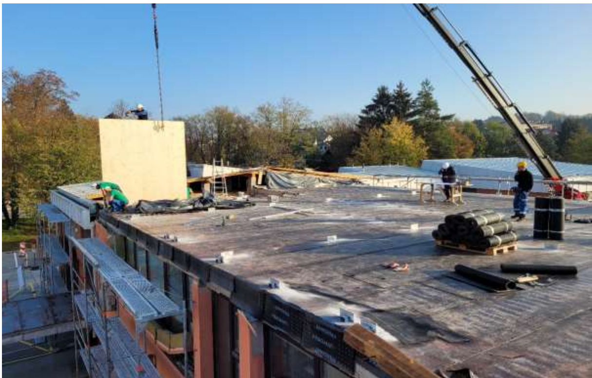
Slika 11 Postavitev prve plošče (02.11.2022)
