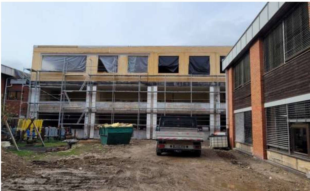
Slika 13 Postavitev nadzidka - pogled z vzhodne strani (21..11.2022)
