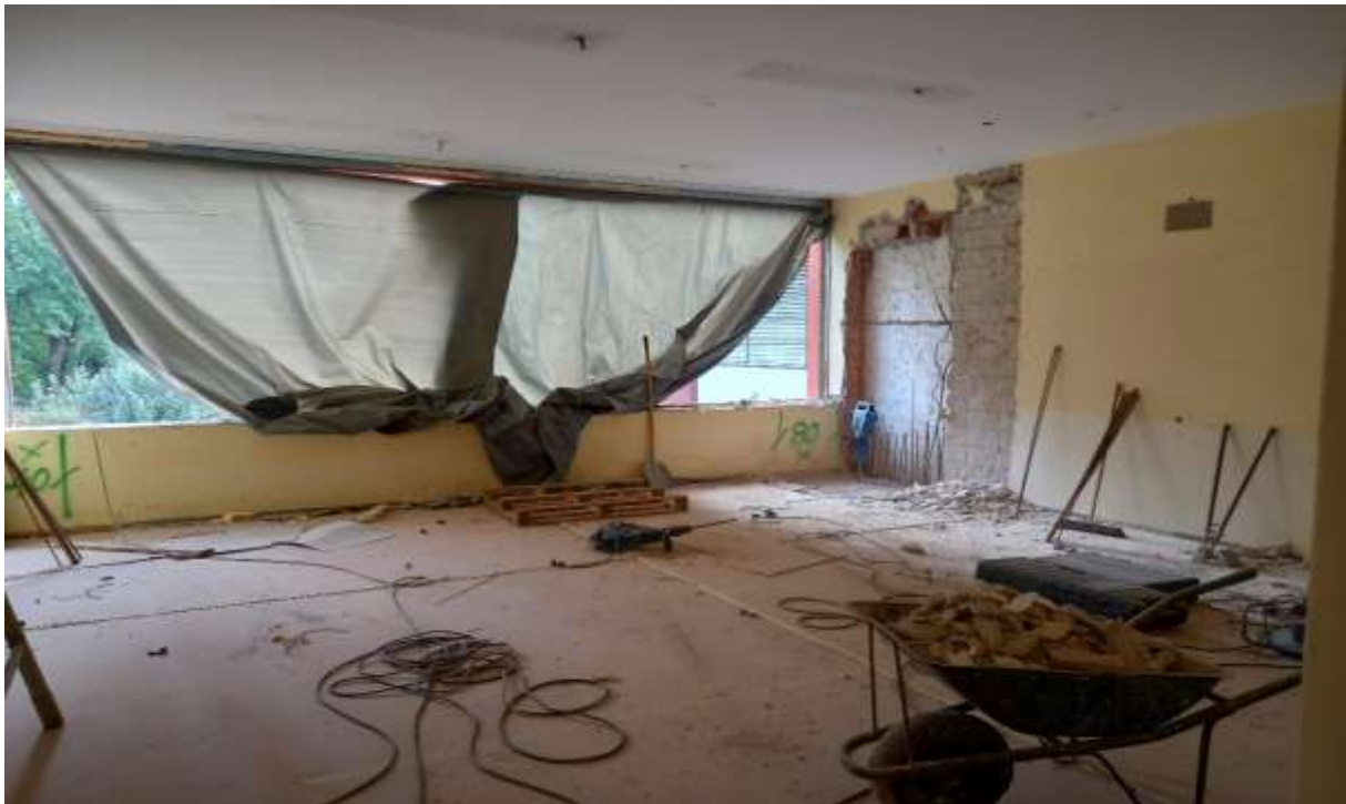
Slika 6 Ojačitev stebrov v prvem nadstropju šole (30.09.2022)
