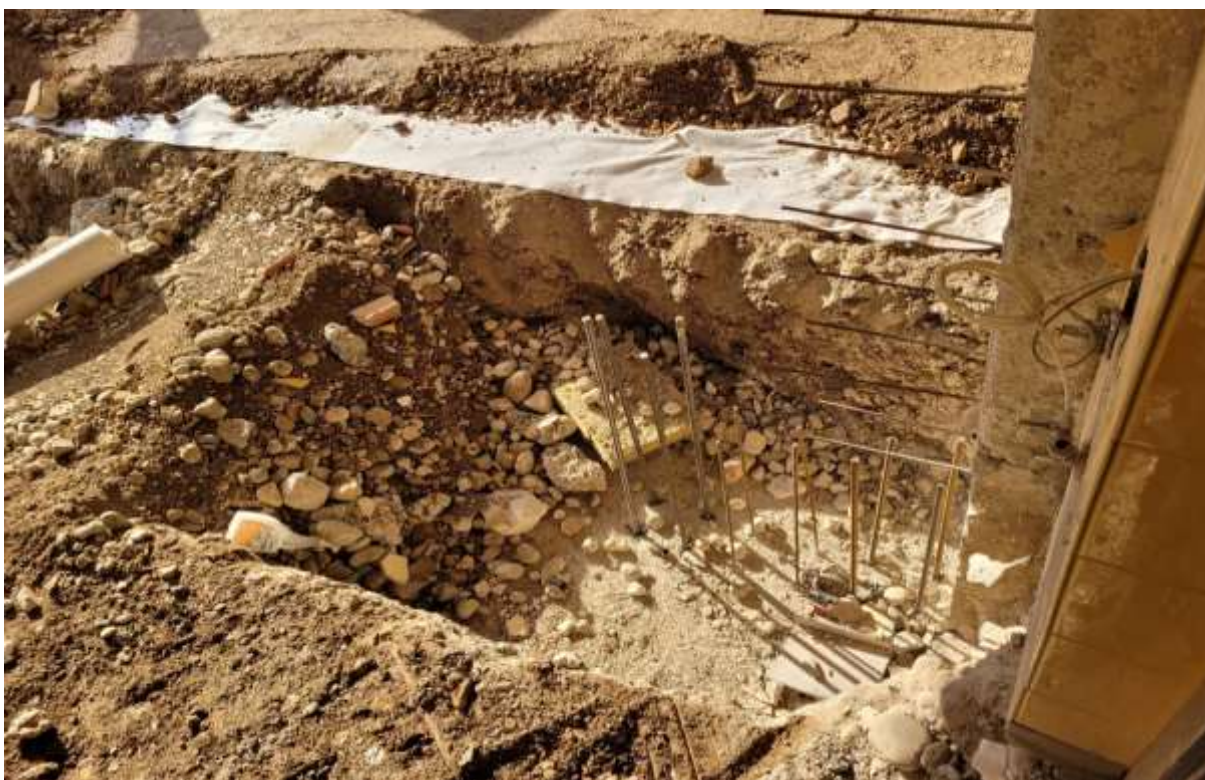
Slika 4 Ojačitev stebrov v pritličnem delu zgradbe (24.09.2022)
