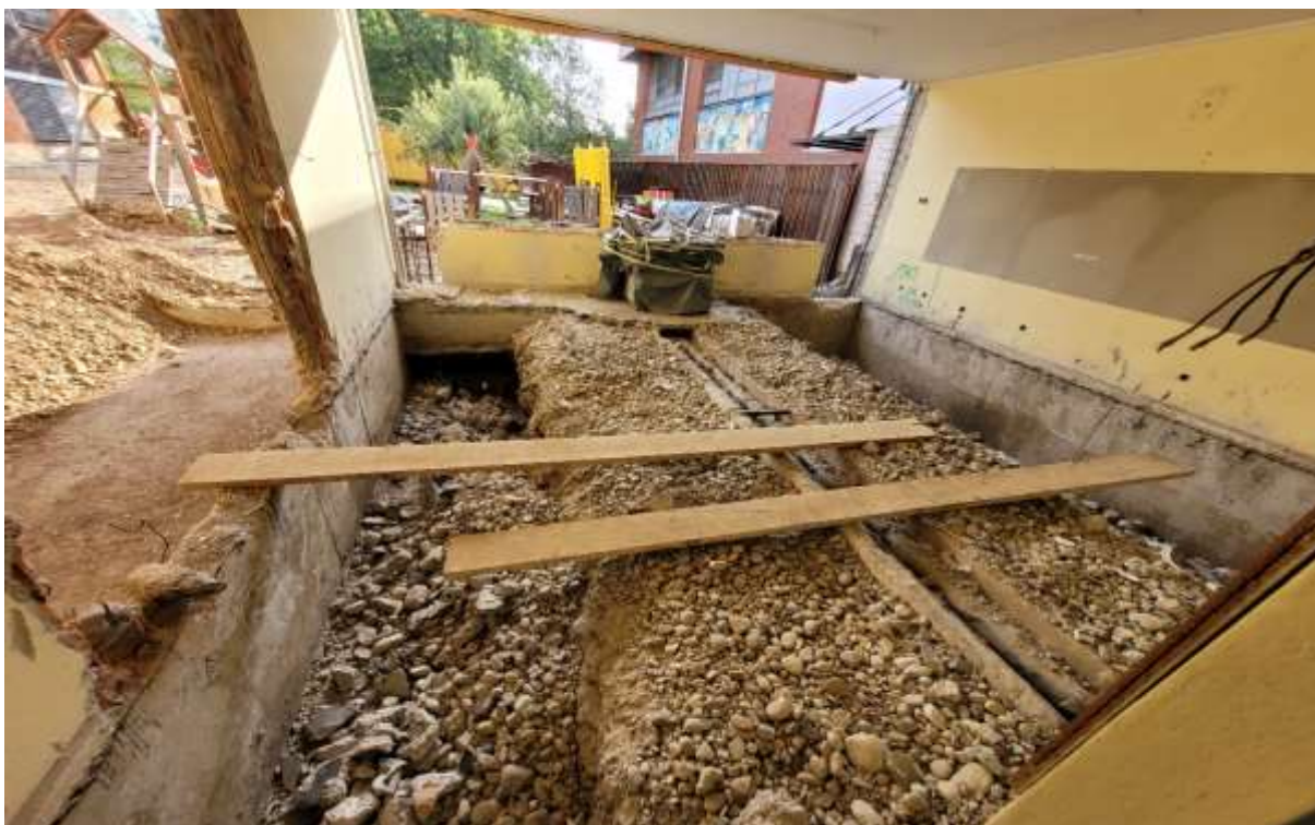
Slika 3 Izkop temeljev za ojačitev zgradbe (24.09.2022)
