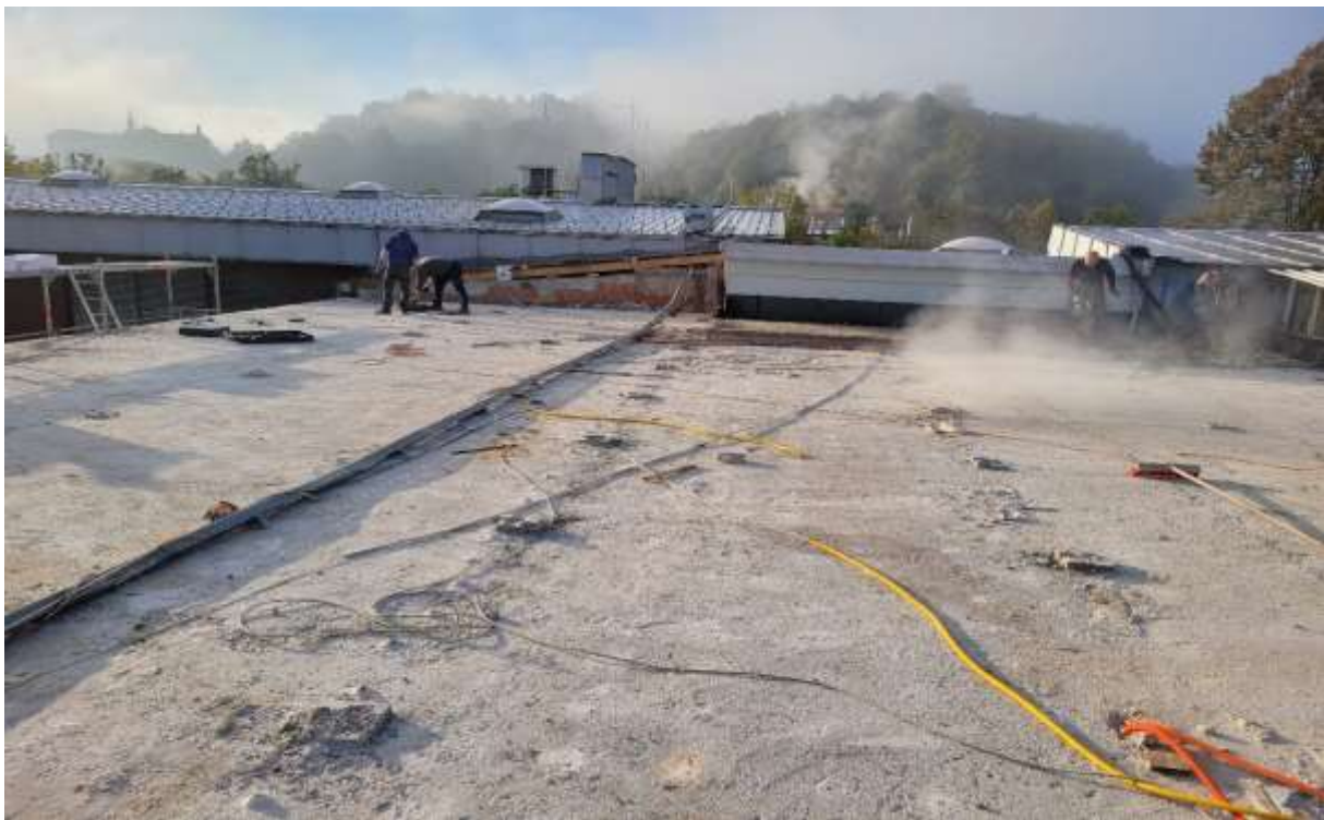
Slika 9 Priprava strehe na betoniranje. Potrebno je bilo zvrtni 3000 lukenj. (19.10.2022)
