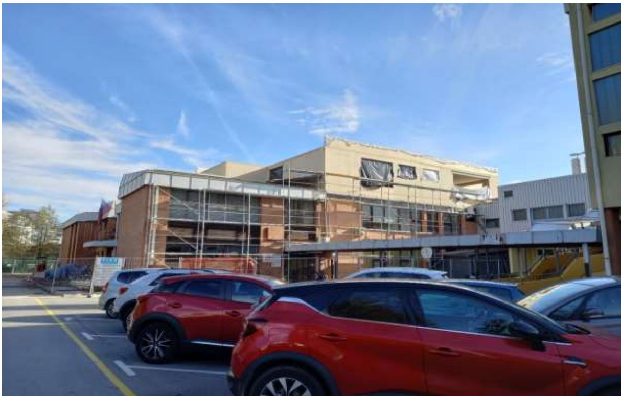
Slika 14 Postavitev nadzidek – pogled z zahodne strani (08.11.2022)
