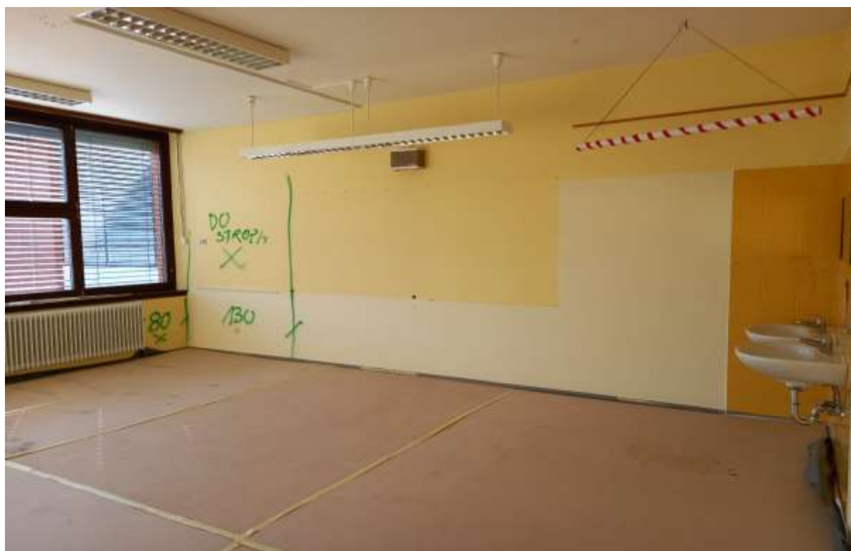
Slika 5 Priprava učilnice na gradbena dela v prvem nadstropju (07.09.2022)
