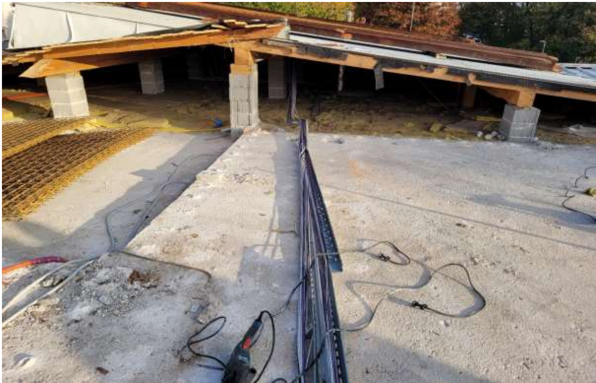
Slika 10 Priprava strehe na betoniranje. (19.10.2022)
