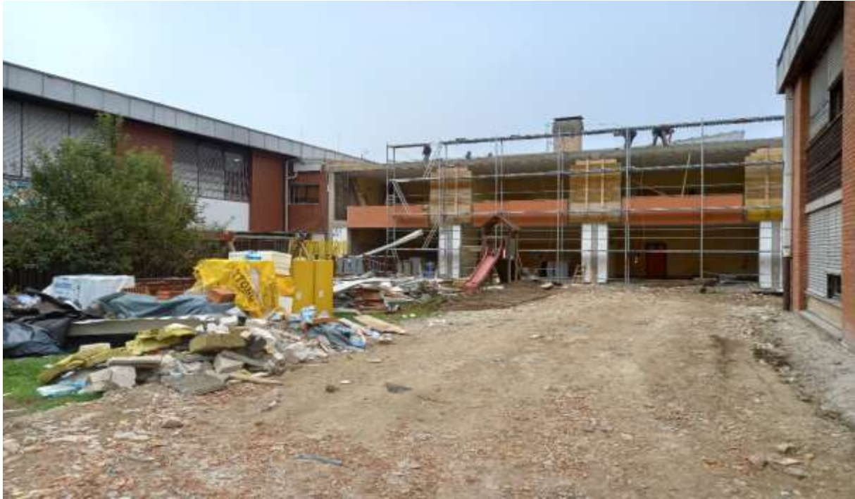
Slika 8 Demontaža obstoječe strehe (17.10.22)
