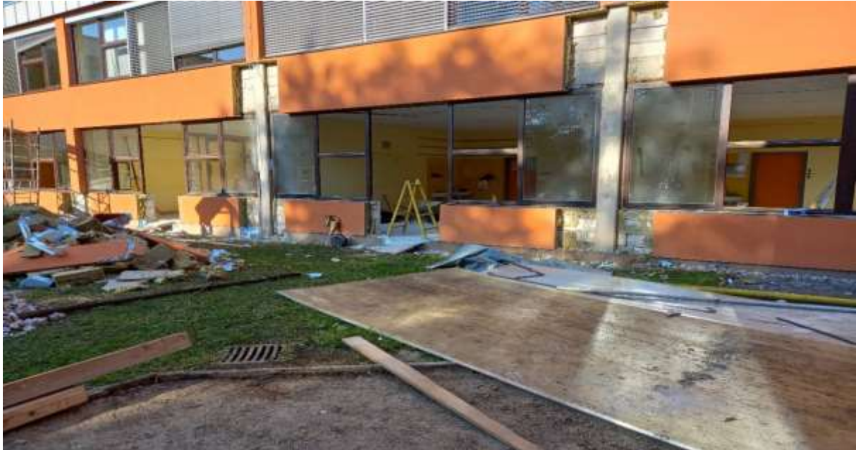
Slika 1 Odstranitev oken in priprava prostorov za ojačitev temeljev in stebrov (02.09.2022)
